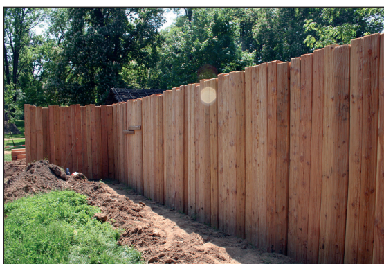
■ Abb. 5 Die Palisade
