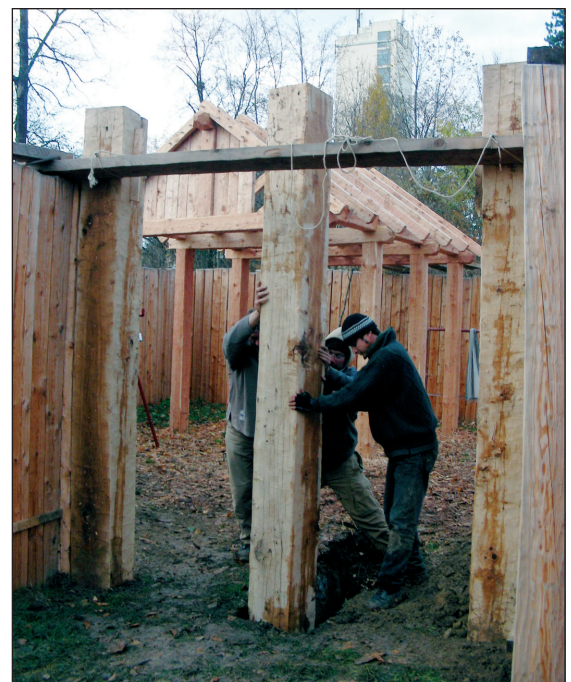
■ Abb. 7-8 Errichtung des Eingangstores
